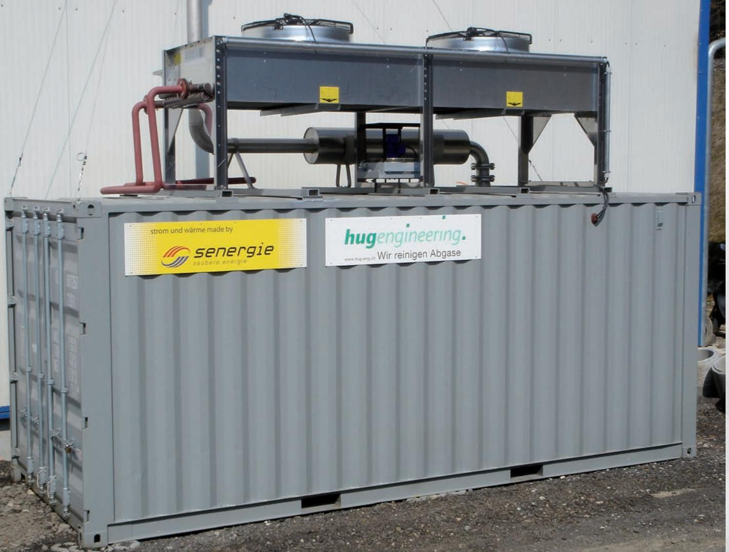
Centrale thermique en montage bloc fonctionnant à l'huile de colza.
