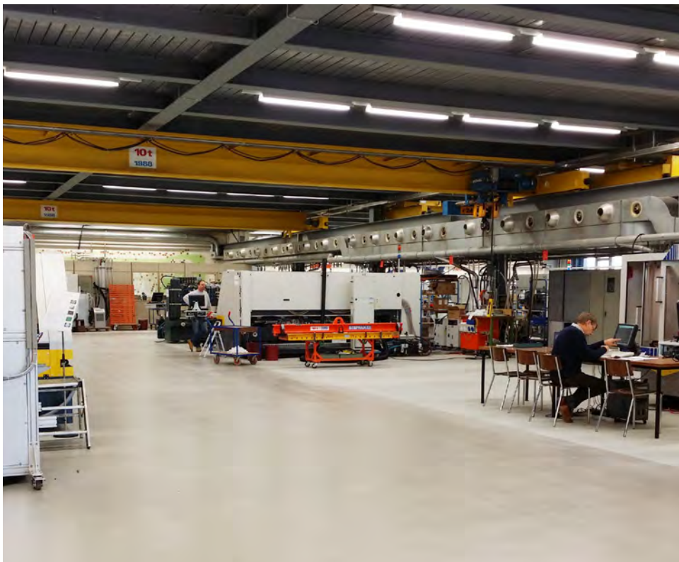
La climatisation avec gestion informatisée et les éclairages basse consommation apportent de substantielles économies thermiques et électriques
