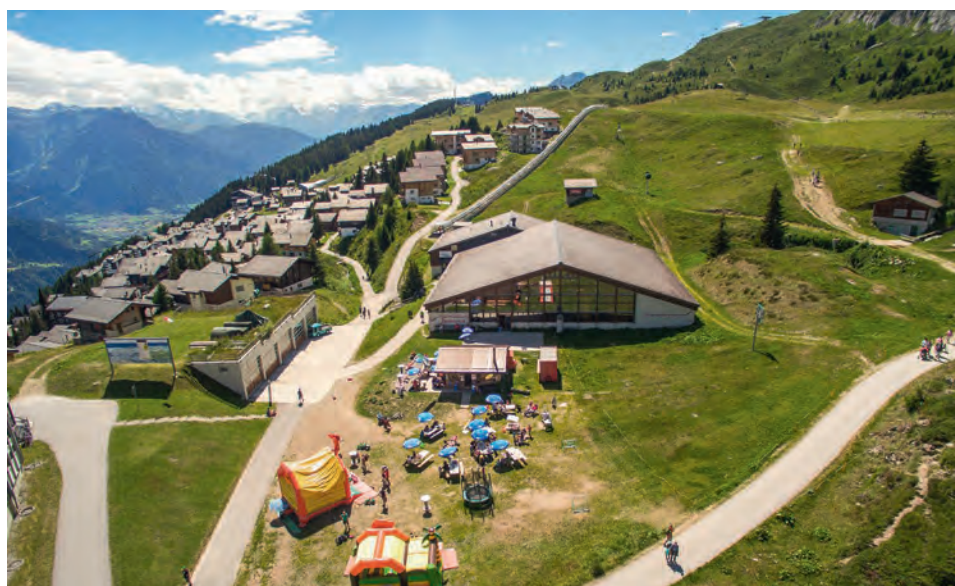
L'ensoleillement direct du centre sportif Bachtla bénéficie aussi à la gestion énergétique du centre !
