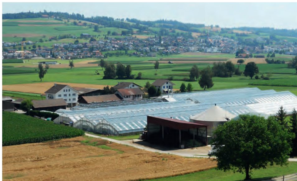
L'exploitation Gebrüder Blaser Agrokulturen et l'installation de biogaz.
