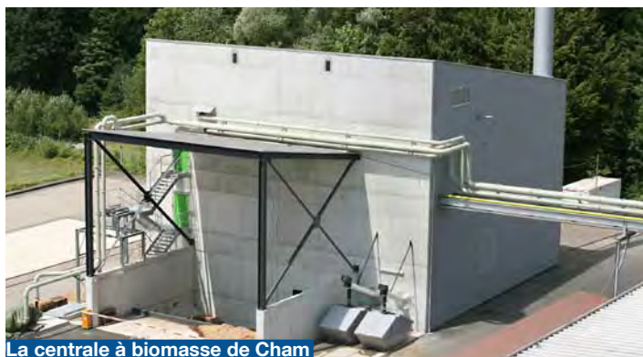
La centrale à biomasse de Cham
