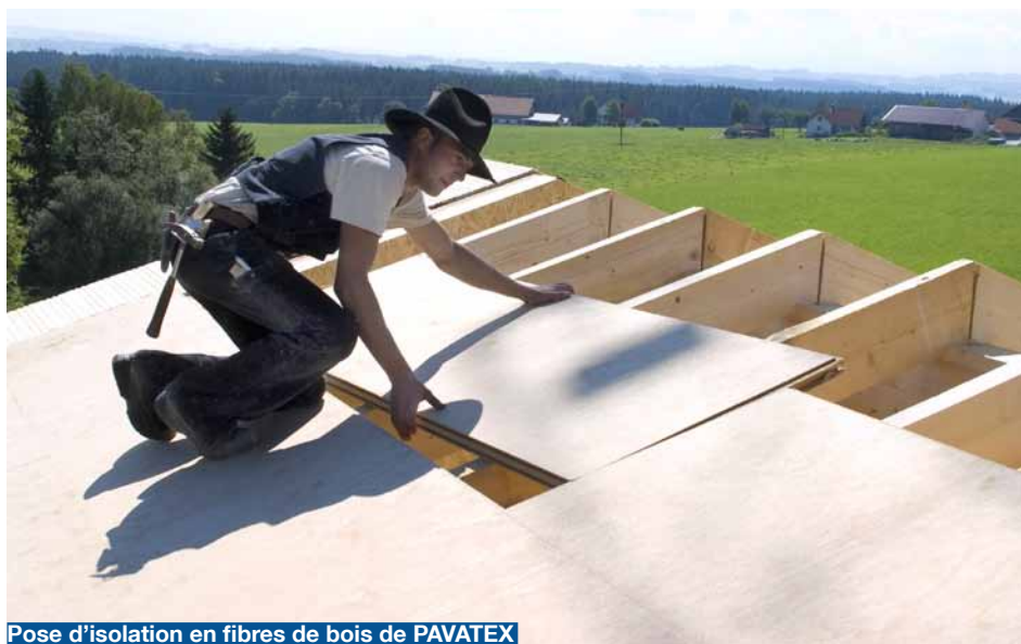
Pose d'isolation en fibres de bois de PAVATEX
