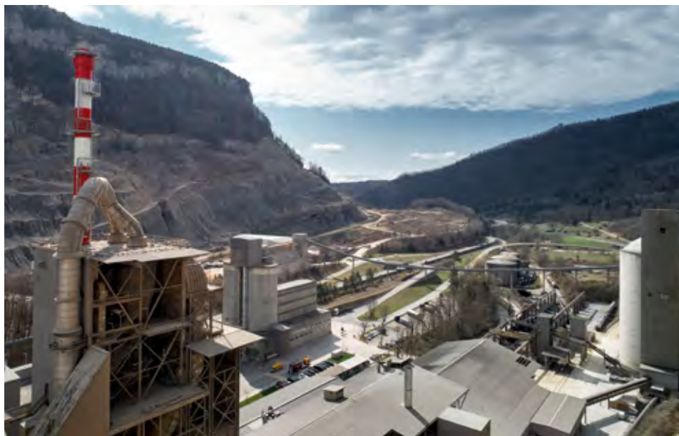
Sur le site de Péry-Reuchenette (BE), les émissions de CO 2 ont été réduites de 34 % depuis 1990, 40 % sont visés à l'horizon 2021.
